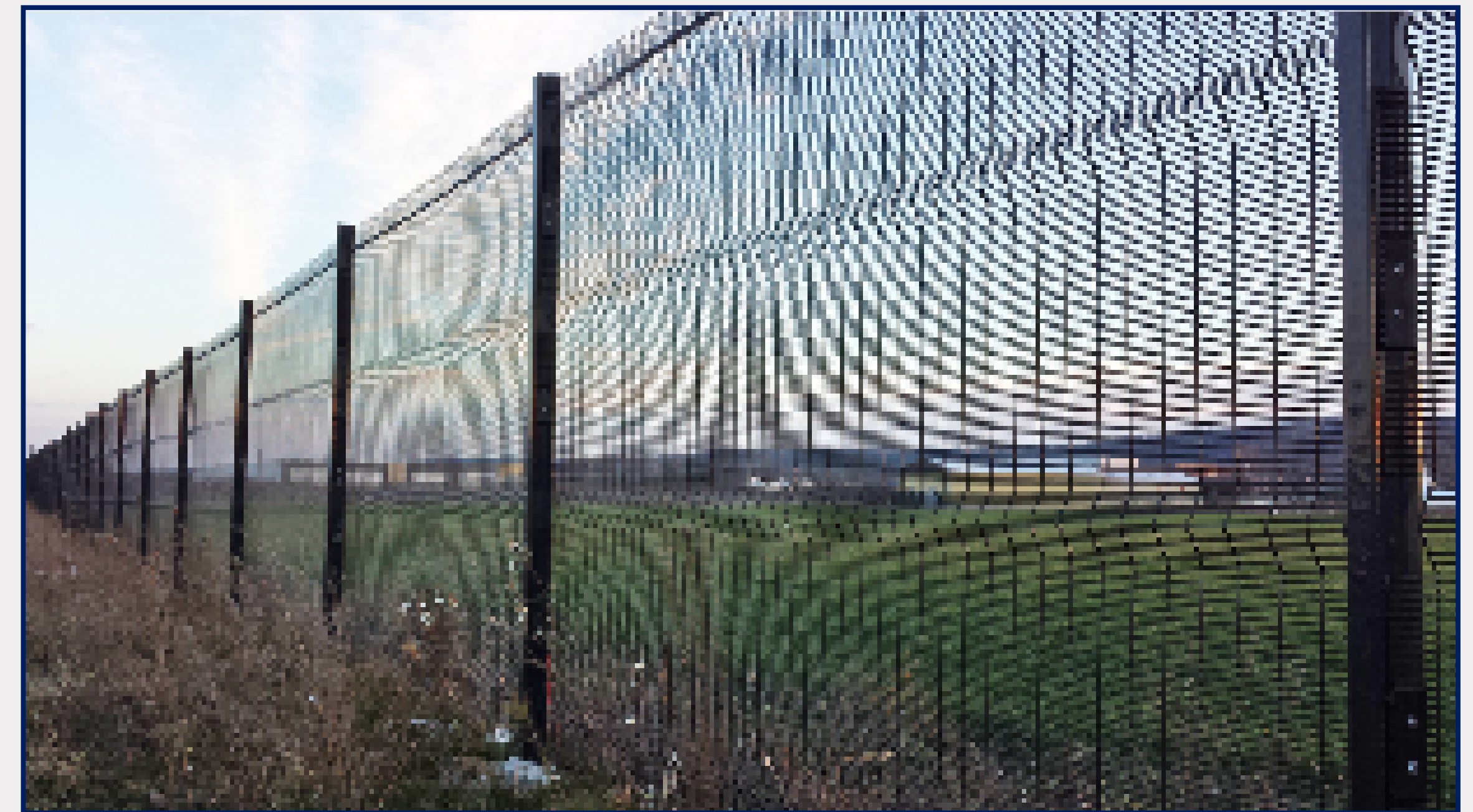
Cercado de alambre soldado
